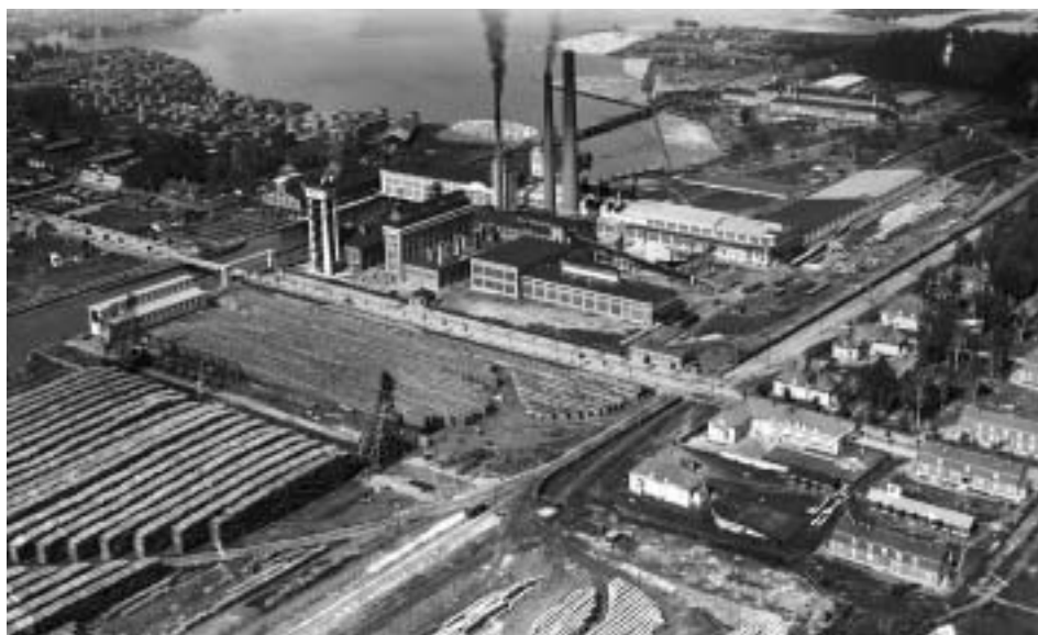
A.Ahlström Oy:n puunjalostustehtaat 1930-luvulla. Oikealla tehtaan työväelleen rakentamia puisia asuinrakennuksia Kommilassa.
